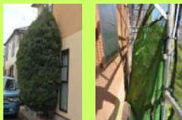
新築の時は背丈も小さい樹で壁との間に隙間が空いていたのに、塗装をする十数年目には大きく育ちすぎて通れない!?ということがありますね。その場合は足場を組んだ後に建物と樹木の間にネットをかけて、できるだけ樹木が壁に当たらないように養生をしています。人は通れなくても手を伸ばせるだけの隙間があれば何とか塗装できます。(できない場合は少し刈らせていただくこともあります)
