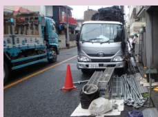
幹線道路で車が多い
