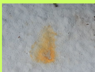
工具の置き忘れによるサビ汚れ
