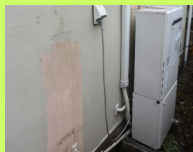
給湯器の移設により、塗装する前の壁が現れました
